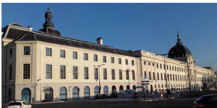
Figure 8 – L'Hôtel-Dieu à Lyon. Combinaison de pierre de Villebois, d'un ton foncé, pour le soubassement et le rez-de-chaussée, et la pierre de Seyssel, bien plus claire, pour les étages (source : Rhônapi)
